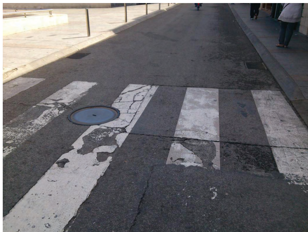
Pavimento agrietado.
